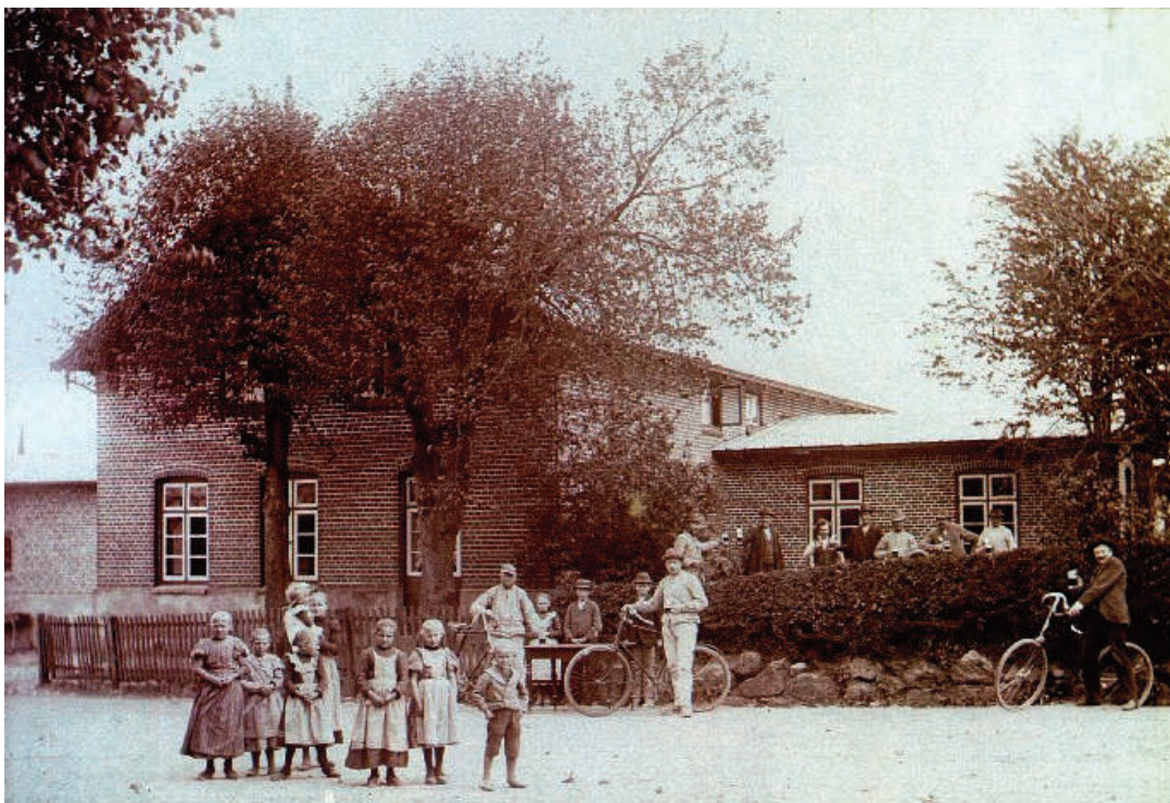
Das ehemalige Gasthaus Lenkersdorf auf einer etwa um 1900 entstandenen Fotografie. Das Gebäude steht noch immer, wenn auch baulich und farblich verändert, an Ort und Stelle aber nur die Bezeichnung der Bushaltestelle davor weist auf dessen einstige Funktion hin.
